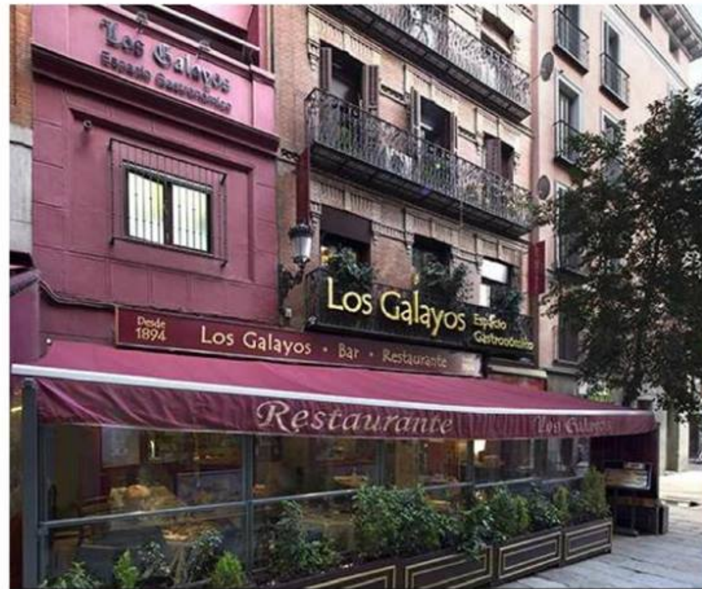
Fachada actual del Restaurante.
