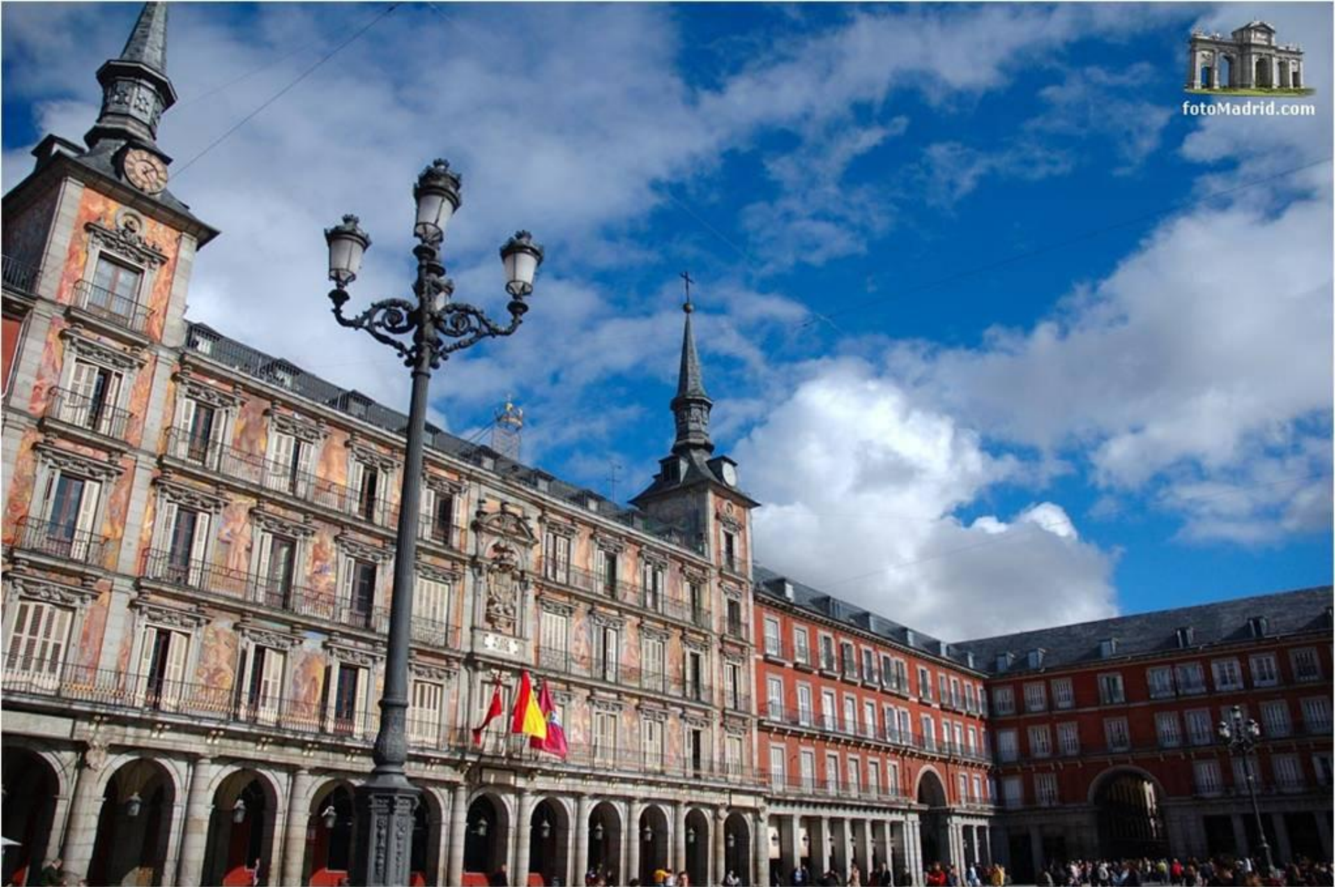
Casa de la Panadería
