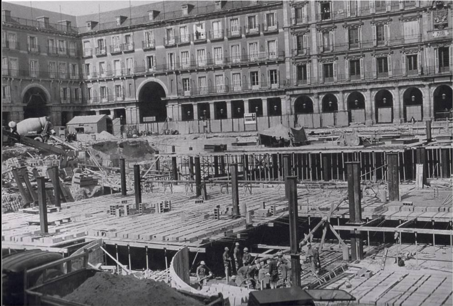
Plaza Mayor, durante la construcción del aparcamiento subterráneo, 1968 Autor desconocido. Colección Izquierdo-Mariblanca (Madrid)
